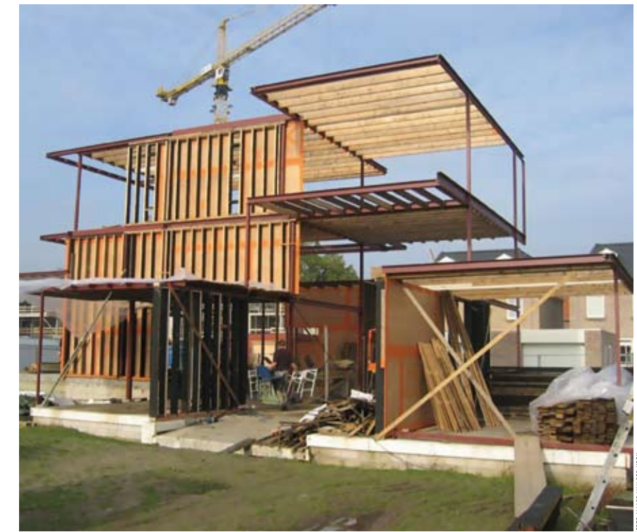
Villa Welpeloo in de wijk Roombeek in Enschede geeft een tweede leven aan ijzeren balken uit oude textielmachines en hout van afgedankte kabelhaspels.
