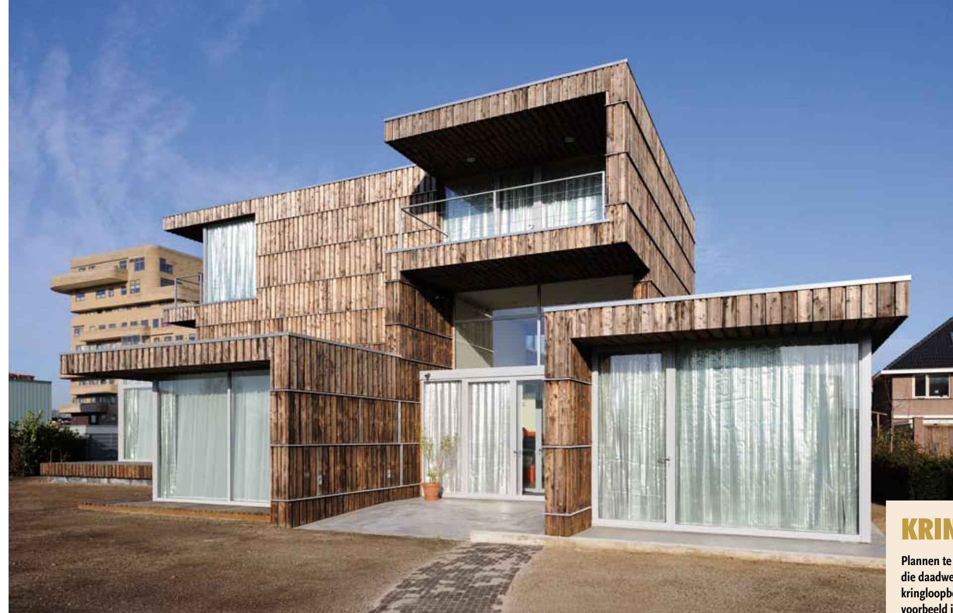
Villa Welpeloo in de wijk Roombeek in Enschede geeft een tweede leven aan ijzeren balken uit oude textielmachines en hout van afgedankte kabelhaspels.
