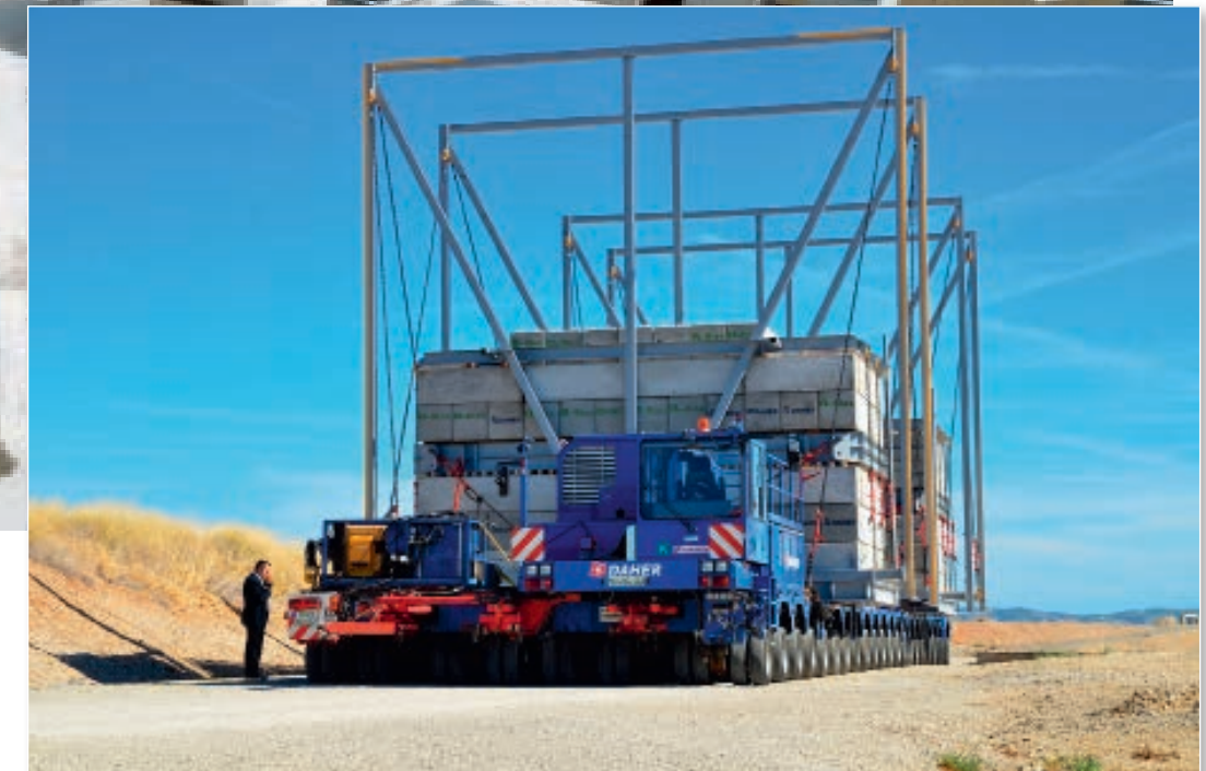
De eerste fase van de fundering van de fusiereactor. De 1,7 m hoge betonnen pilaren hebben een aardschokbestendige bovenkant.
