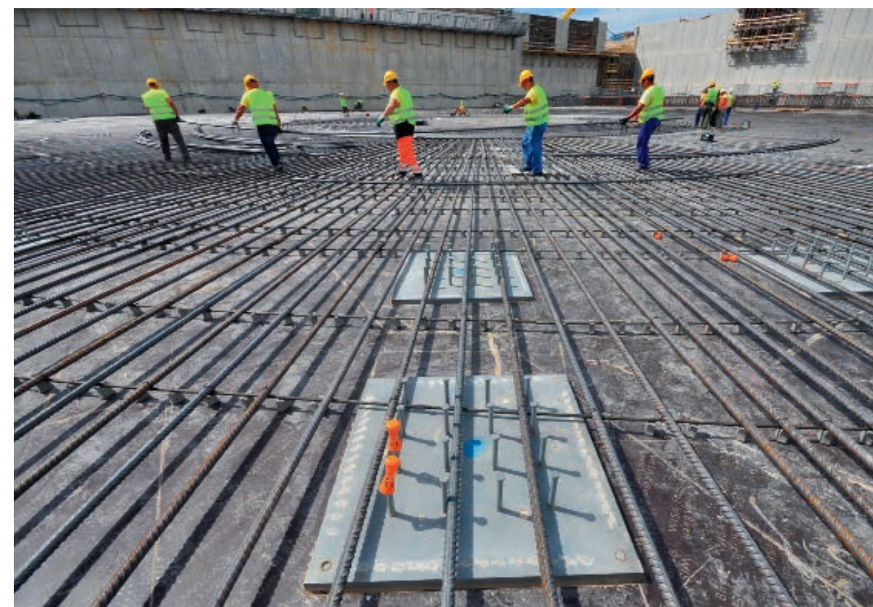
Foto boven: Betonvlechters werken aan de vloer, die de 23 000 ton wegende reactor moet dragen.
