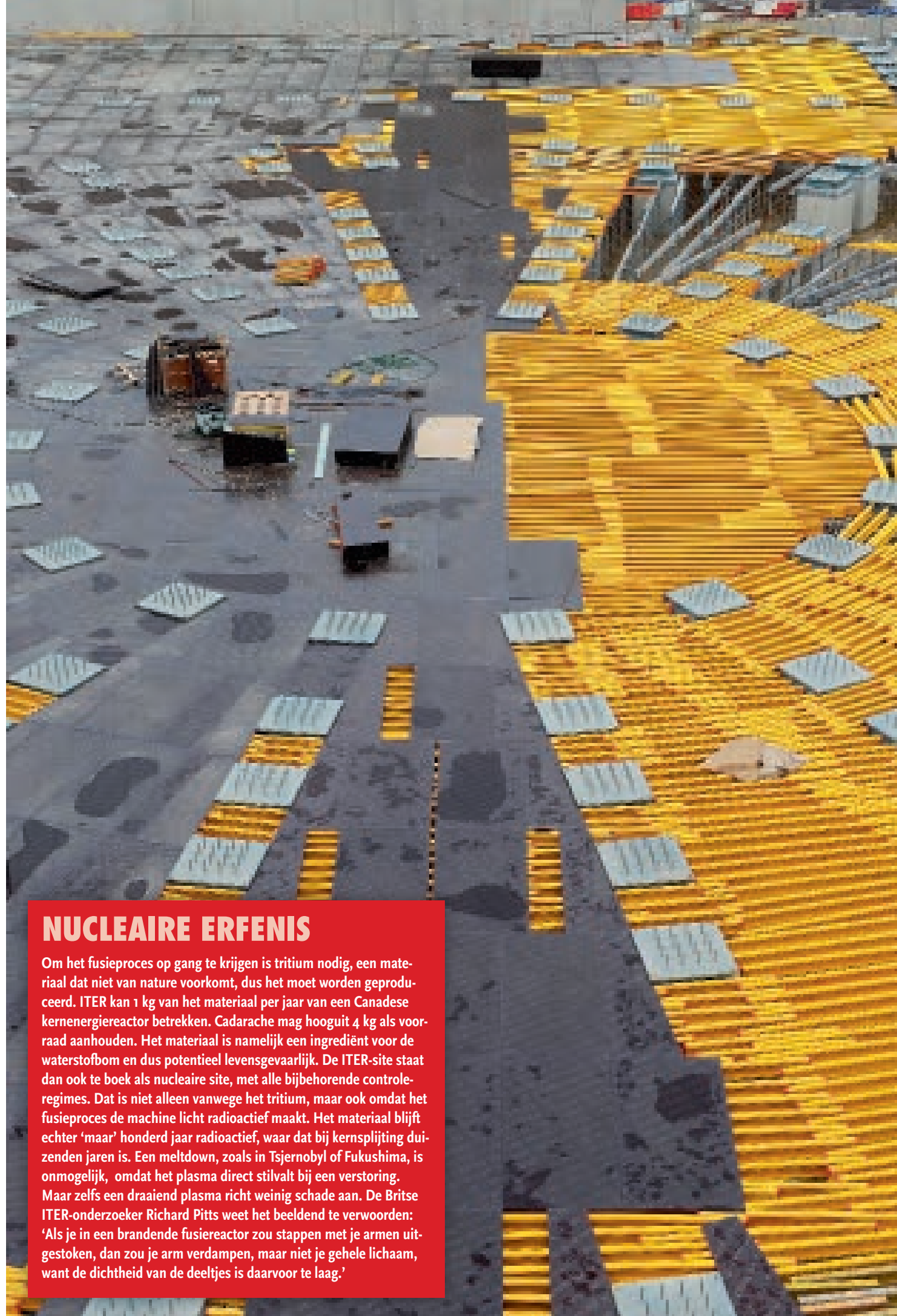
Foto boven: Betonvlechters werken aan de vloer, die de 23 000 ton wegende reactor moet dragen.
