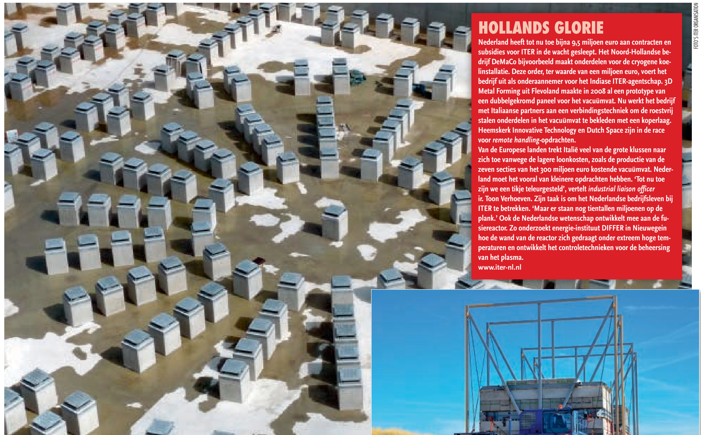
Het testtransport naar de bouwput van ITER, met 800 ton aan betonblokken.
